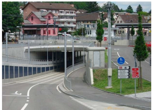
SH, Route 77, Neuhausen: passage inférieur pour vélos 6
