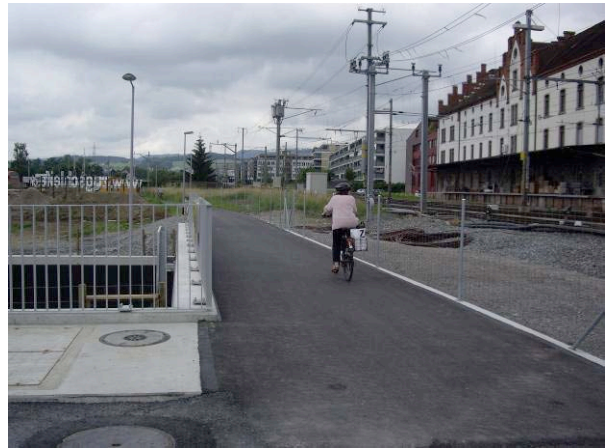
ZG, Routen 9 / 51 / 94, Zoug: nouveau passage supérieur 2
