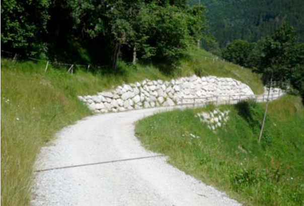
GR, Route 2, Trun-Valendas: Amélioration au chemin 1
